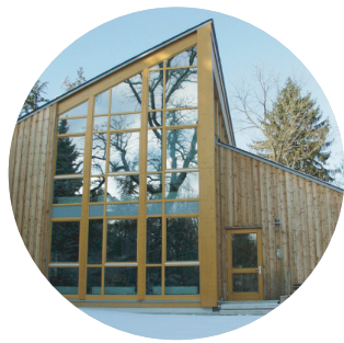
Verwaltungs- gebäude (B)
